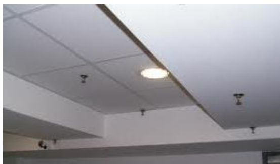
Figura 6.14 Instalațiile de stingere a incendiilor utilizate la protecție
