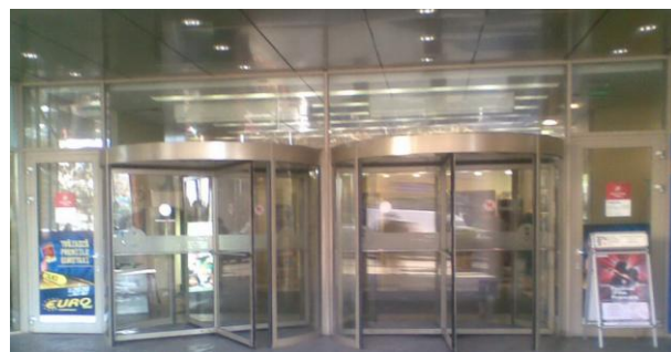
- dublarea ușilor rotative cu uși de evacuare
